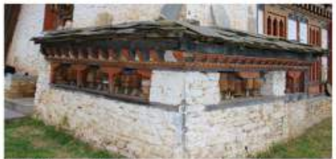
D. Mini mandungkor along outer wall
